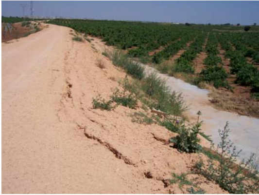
Camino al colector de aguas residuales (media legua)
